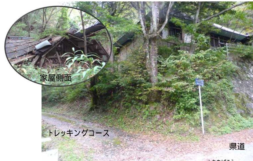
写真1: 道路に隣接する荒廃空き家(下上籠)
