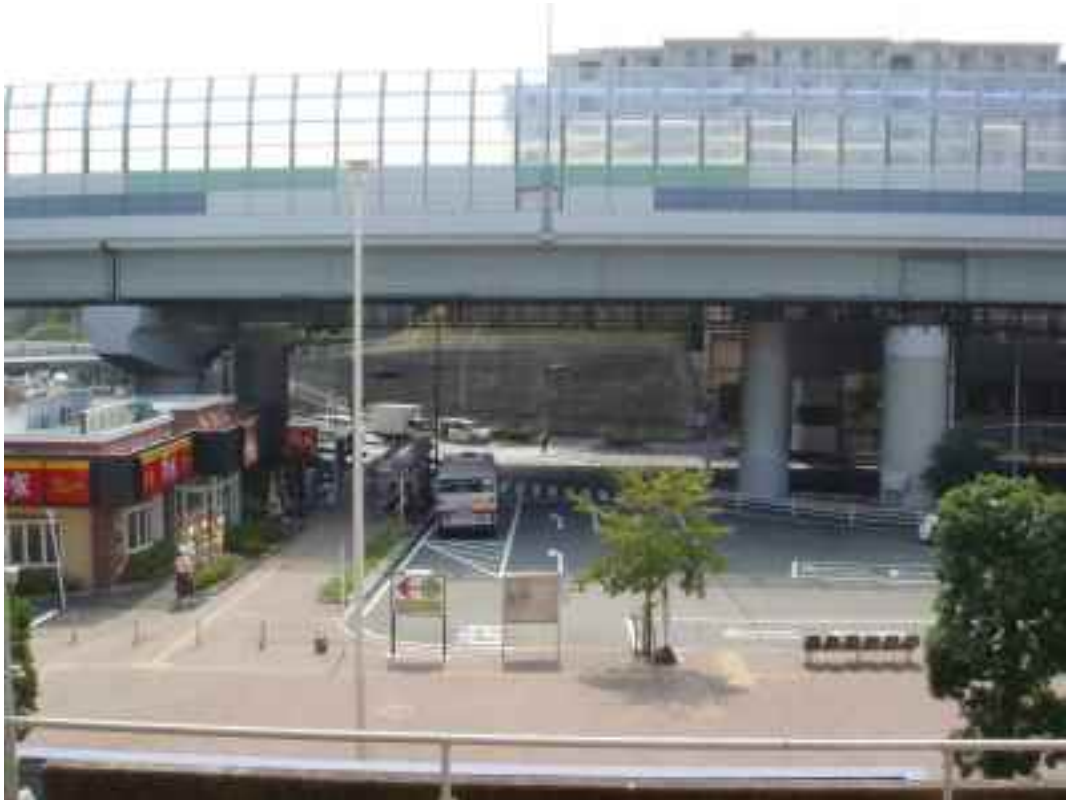
図 3-17 江田駅東口駅前広場の現況写真 1
