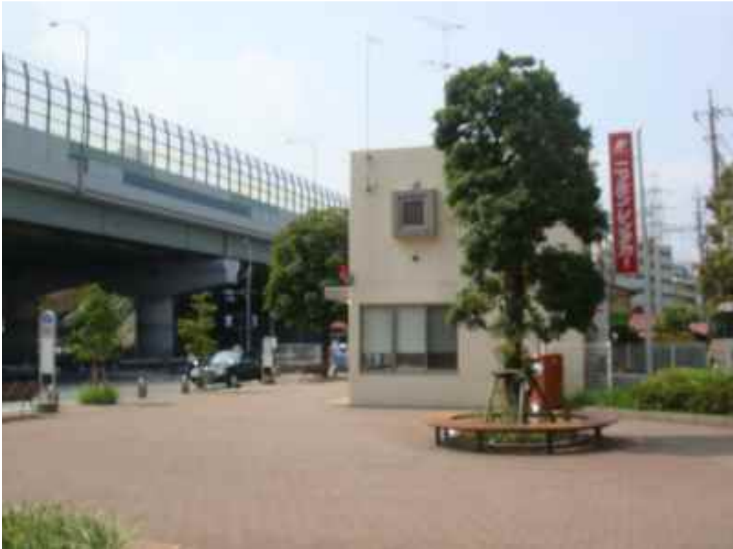
図 3-18 江田駅東口駅前広場の現況写真 2
