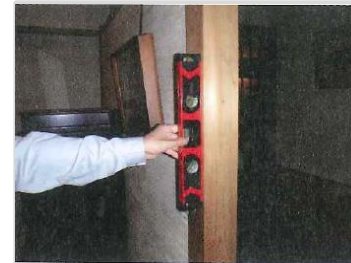
水平器による柱の傾きの計測
