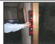
水平器による柱の傾きの計測
