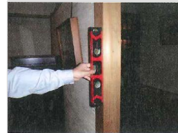
水平器による柱の傾きの計測
