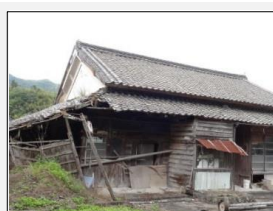
損傷の激しい家屋の敷地
