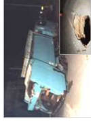
下水道の老朽化による道路陥没
