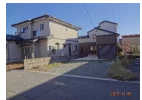
【空き地B】住宅建設後
