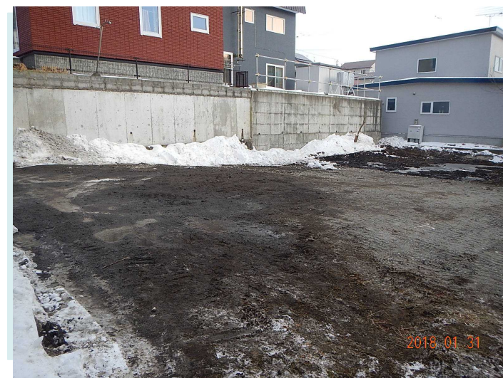
解体・譲渡後
