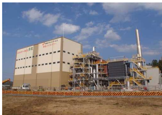
バイオマス発電所「多気バイオパワー」
