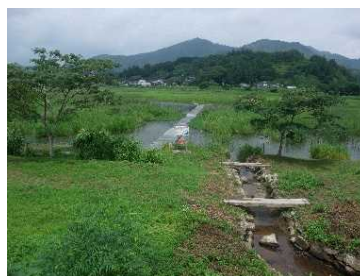
日下川調整池 全景
