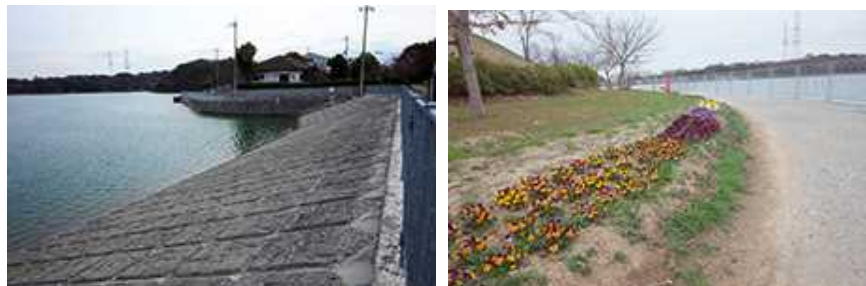
改修した副堤防（平成30年3月撮影）
