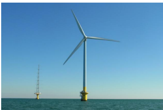
図 3.1.18 銚子沖風力発電施設（重力式） （出典：NEDO、2014）
