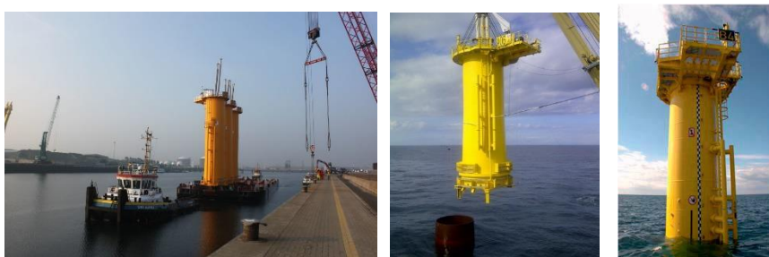
図 3.2.17 トランジションピースの運搬と設置
