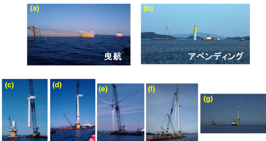
図 3.3.17 浮体式風車の曳航と設置の様子 (Hywind の例) (出典 : NEDO、2015)
