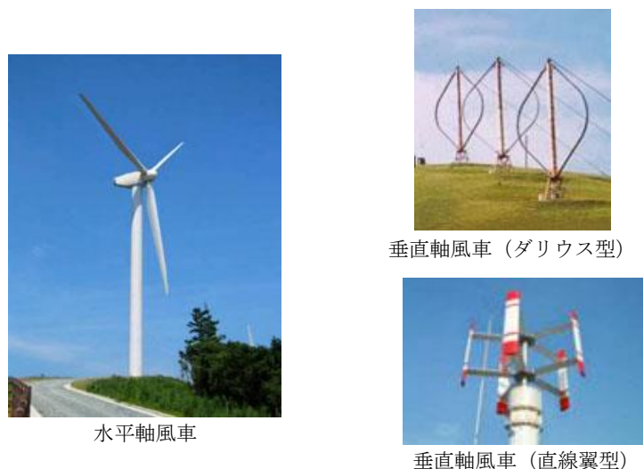
図 3.1.2 水平軸風車と垂直軸風車 (出典：三菱重工業ウェブサイト)
