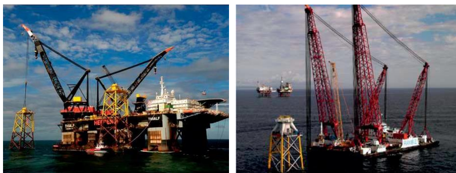
図 3.2.22 ジャケットの吊り上げ (左) と据え付け (右) 状況 (出典 : (左) Ballast Nedum 社ウェブサイト、(右) Robertson J、2008)
