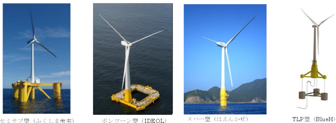
図 3.3.3 浮体式洋上風力発電の浮体形式 (出典：(左から順に) 福島洋上風力コンソーシアムウェブサイト、IDEOL 社ウェブサイト、提供・海上技術安全研究所、BlueH Engineering 社ウェブサイト)
