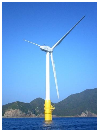
図 2.1.1 浮体式洋上風力発電施設「はえんかぜ」 (提供：海上技術安全研究所)
