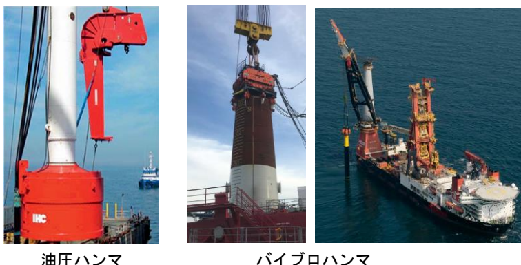
図 3.2.16 モノパイル打設の工法
