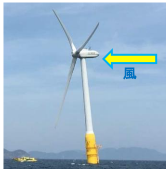
図 3.1.6 長崎県五島市沖の浮体式風車 (出典：海洋エネルギー資源利用推進機構、2016)
