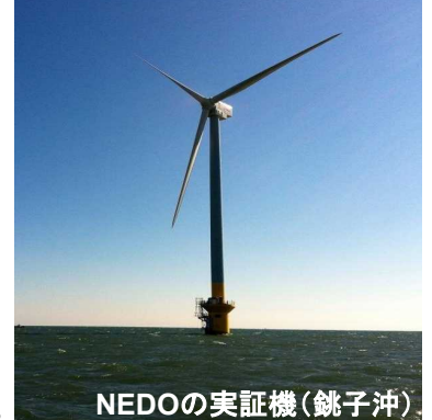
【洋上風力発電設備のイメージ】
