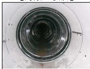
内面バンド設置状況
