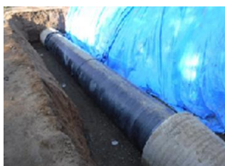
鋼管敷設状況
