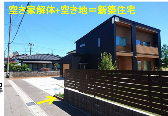
敷地W=1.5mの寄付で市道拡幅
