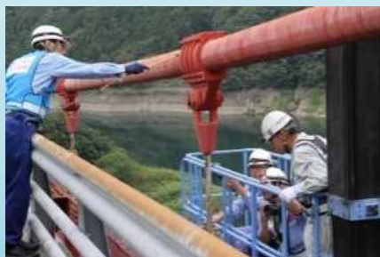
▲国道メンテナンス
