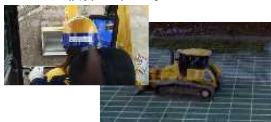
ICT建機による施工
