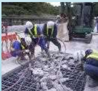
▲修繕・耐震補強
