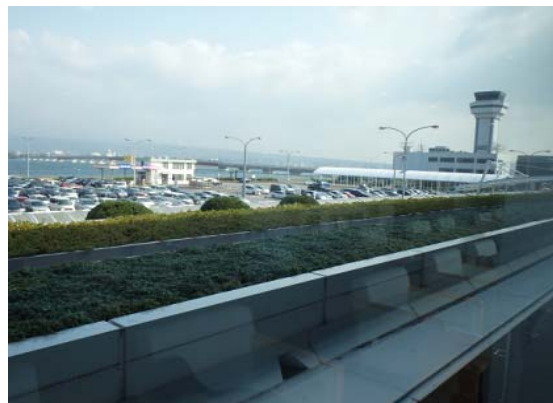
■旅客ターミナルビル庇の緑化
