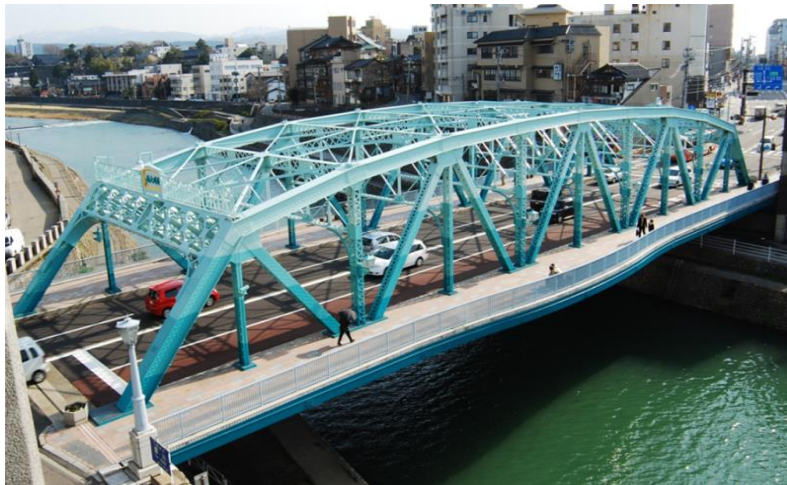
図 8-7 国道 157 号犀川大橋
