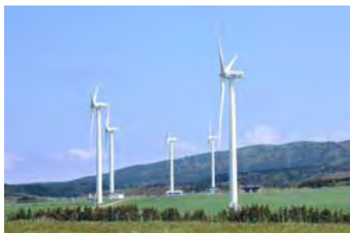
六ヶ所村の風力発電所
