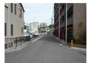
新設された区画道路
