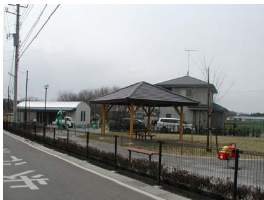
新設された広場と集会所
