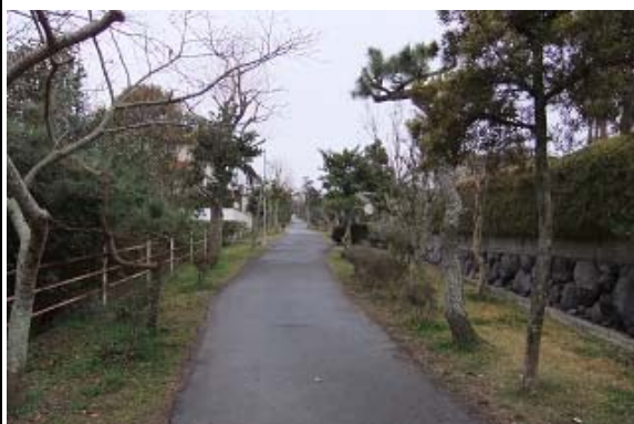
主たる出入口を設けることを禁止した緑道
