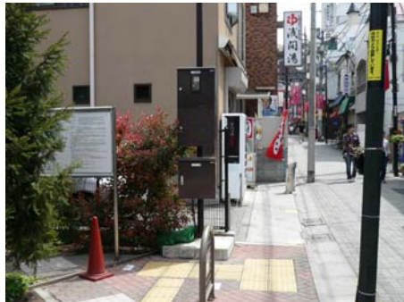
建替え時にセットバックした建物
