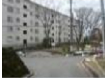
・EV未設置の住棟
