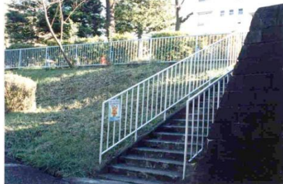
・敷地内随所にある階段
