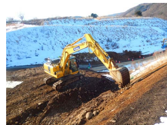
「ICT土工体験講座」 (長野県建設業協会)
