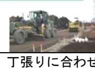
検測と施工を繰り返して整形
