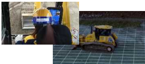
ICT建機による施工
