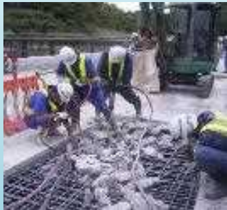
▲ 修繕・耐震補強
