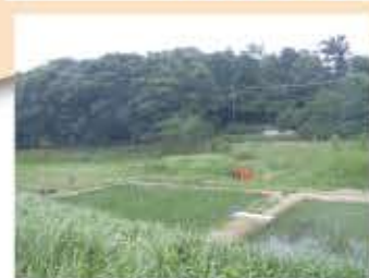
都市部の防災を担いつつ身近な自然の保全・再生の場としても活用される洪水調節池 (東京都野川)
