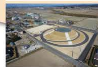
平時は地域のコミュニティ施設として機能しつつ、津波の災害時には避難場所となる命山 (静岡県袋井市)
