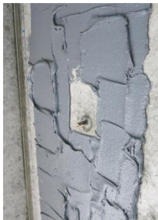
(接着材の塗布状況)
