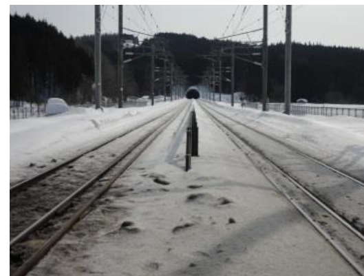
明かり区間の冬期状況
