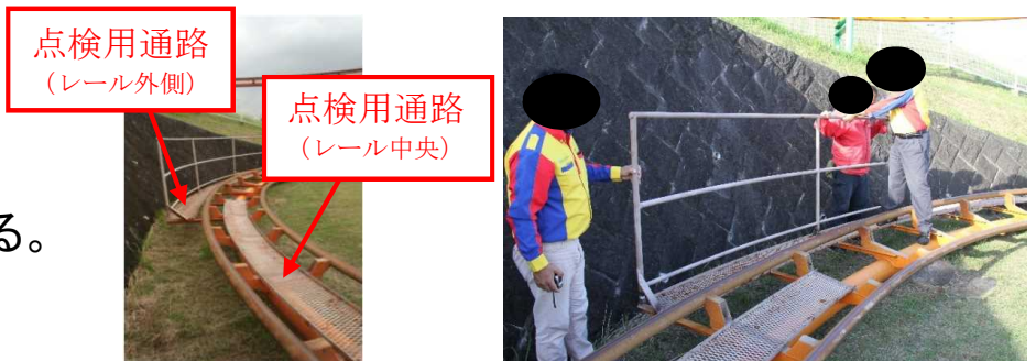
写真1 点検用通路と手すり
