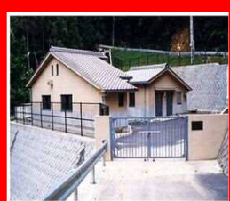
尾山地区処理場
