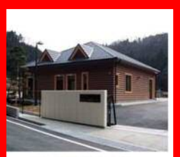
東部第1地区浄化センター
