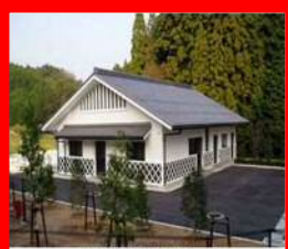
田原地区浄化センター
