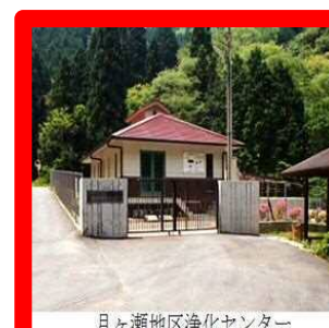
月ヶ瀬地区浄化センター
