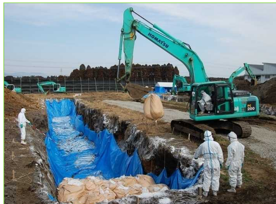
平成22年 宮崎県口蹄疫被害における家畜埋却作業(宮崎県建設業協会)
