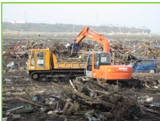
南相馬市 瓦礫撤去作業(福島県建設業協会)
