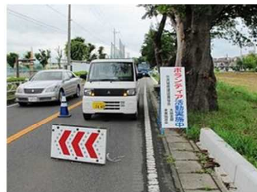
縁石設置工事
