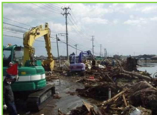
仙台市 道路啓開作業(宮城県建設業協会)
