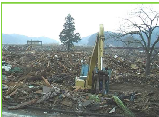
陸前高田市 道路啓開作業(岩手県建設業協会)
