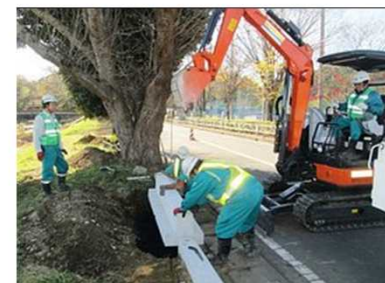
縁石設置作業
