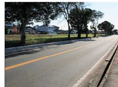
縁石設置完了
