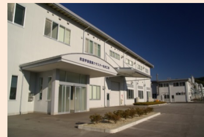
クラスター拠点整備工場
