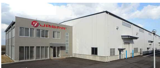
写真:航空機エンジン部品共同工場 航空機エンジン部品の一括受注生産を実現 (出典:JASPA 株式会社)
