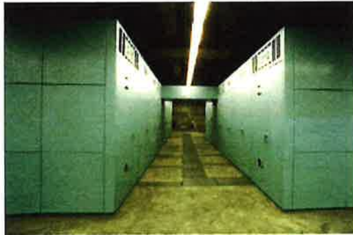
新千里変電所特高閉鎖配電盤・真空遮断器更新
