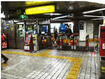
〔 千里中央駅南・北改札、 桃山台駅南改札改造工事 〕
