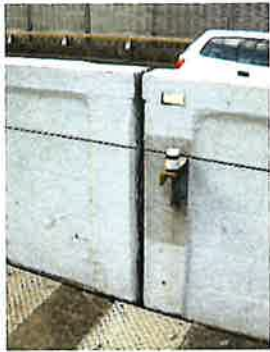
既設ブロック高欄
