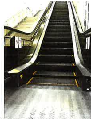
〔 緑地公園駅、千里中央駅エスカレーター改修 〕
