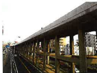
FRP製高欄設置状況
