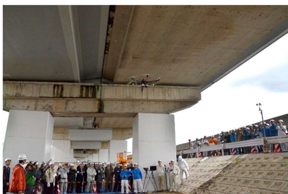
橋梁点検ロボット現場検証
