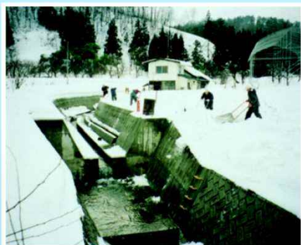
除排雪低水路(山形県村山市)
