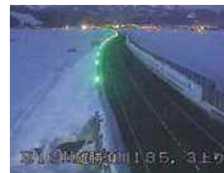
自発光式LED視線誘導標 (湯沢河川国道事務所管内)
