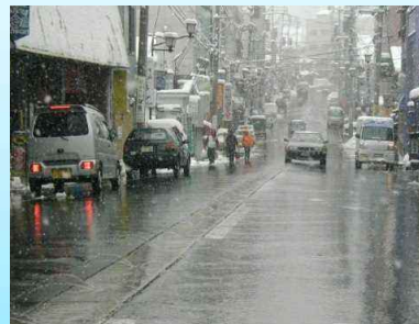
下水処理水を活用した消雪
