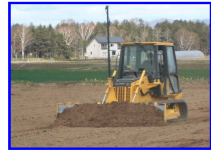
田面均平化作業(2015/4) (精度±15mm)
