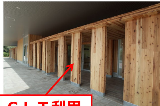
④ 粟津工場 新食堂 内外装材にかが杉を利用、テラス部などにCLTを利用（2016年4月竣工）
