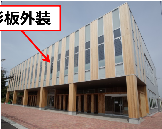
④ 粟津工場 新食堂 内外装材にかが杉を利用、テラス部などにCLTを利用（2016年4月竣工）
