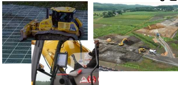
ICT建機での施工
