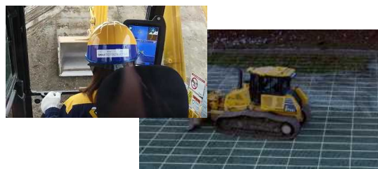
ICT建機による施工
