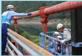
▲ 国道メンテナンス
