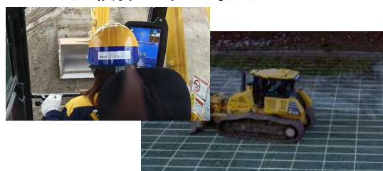
ICT建機による施工
