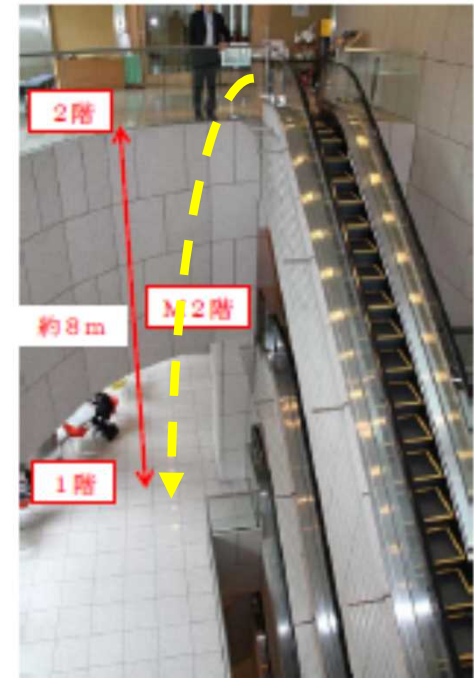
写真1. 事故が発生した吹抜け部分
