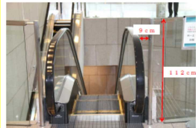
写真2. 吹抜けに面する部分の安全柵
