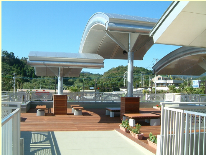
トイレ屋上展望台
