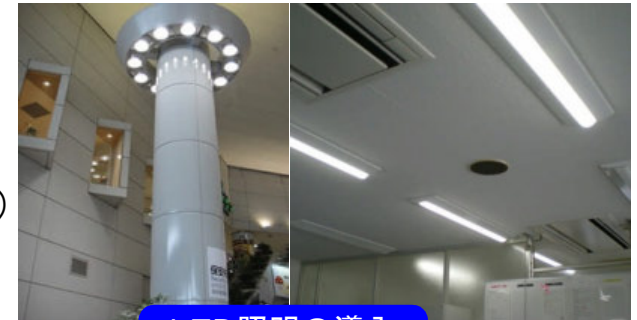
LED照明の導入
