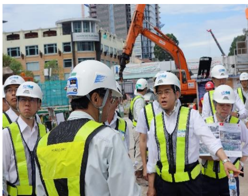
ホーチミン都市鉄道工事現場視察
