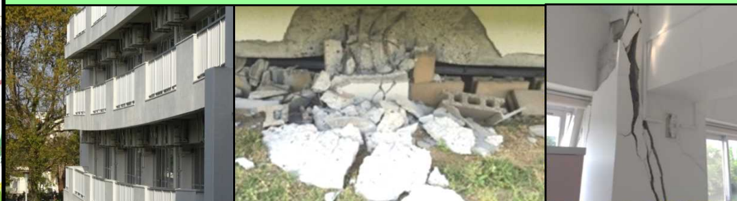
建物の変形（たわみ）
