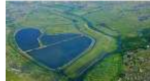
↑ 遊水地として治水機能を確保すると共に、水質改善や生態系保全にも寄与(渡良瀬遊水地)
