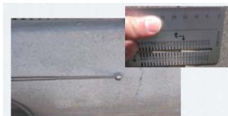
基礎目視検査(クラックの幅をクラックスケールで計測)
