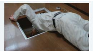
床下点検口より覗き込み、目視・触診可能な範囲の異常の有無を確認。
