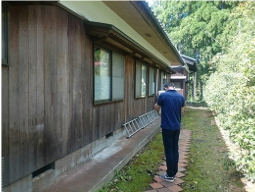
写真 3 劣化診断時の写真
