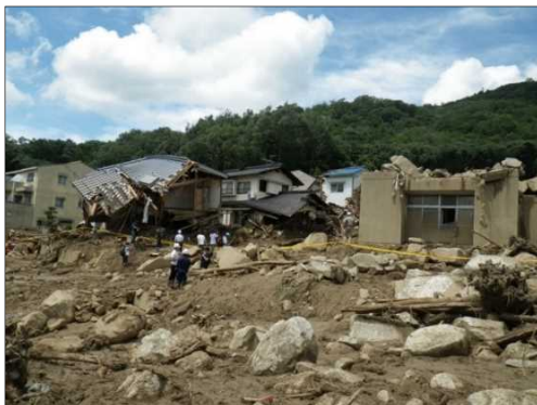
被災状況(八木地区)
