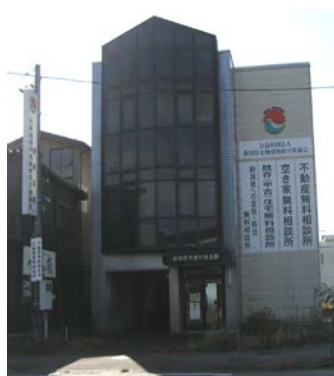
写真8 壁面看板（正面）
