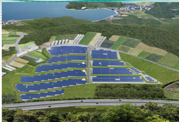
■メガソーラーの誘致(静ヶ谷最終処分場) ※平成25年7月発電開始
