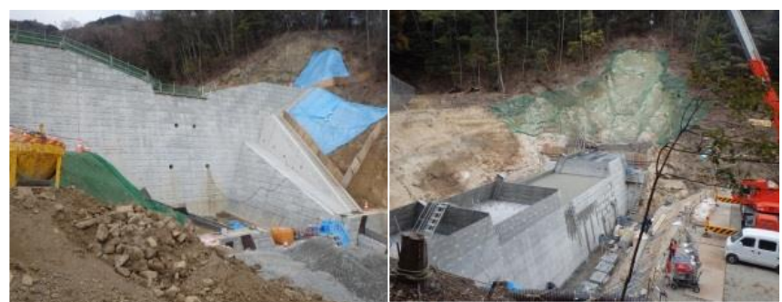
安佐南区八木地区の進捗状況(H28.1.13撮影)
