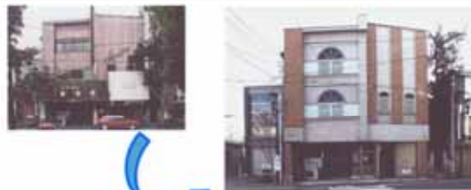
ファサード改修事例
