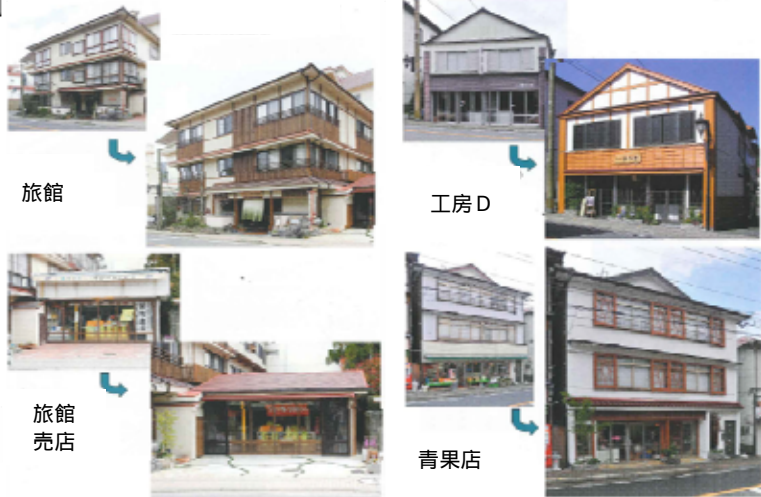
ファサード改修事例
