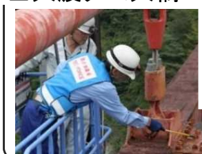
ケーブルのカーブ部の腐食
