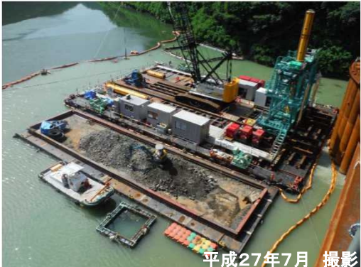
④流入部(前庭部) 水中バックホウ掘削
