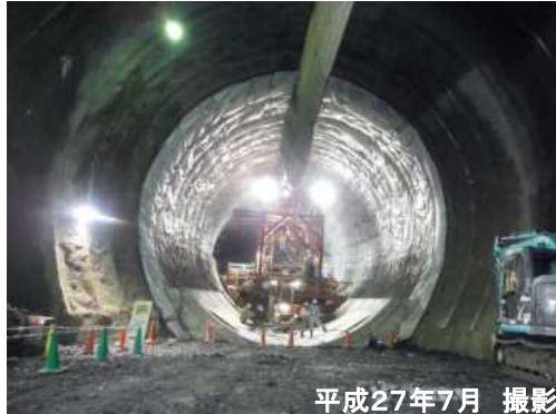
③導流部 トンネル覆工
